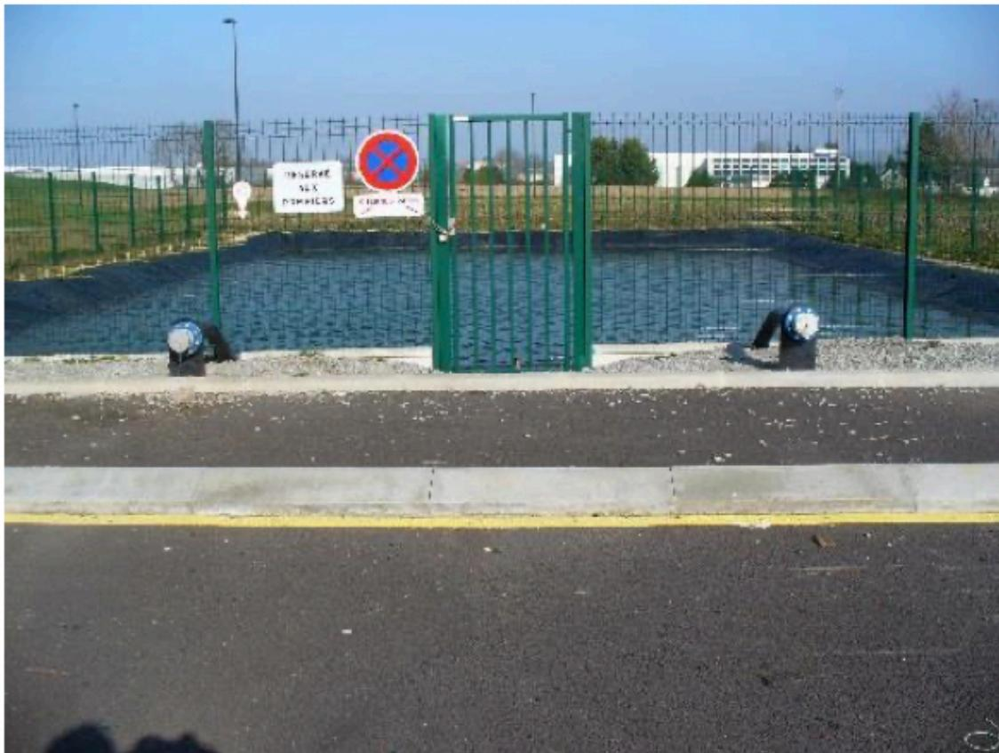
*Illustration n°7: Photo d'une réserve artificielle - réservoir ouvert*
