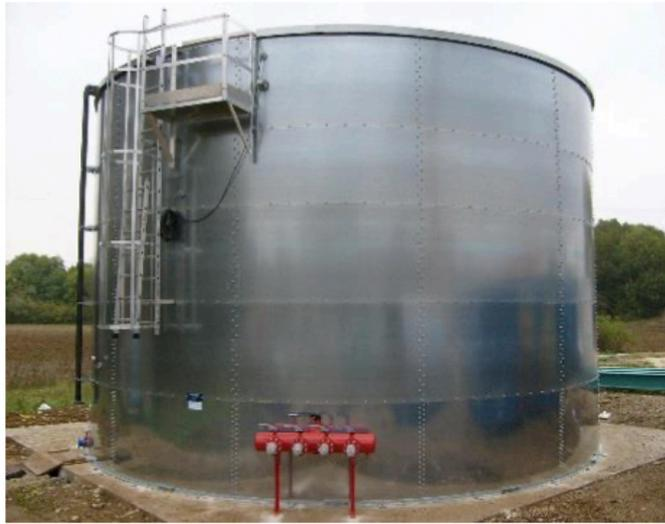
Illustration n°10: réservoir aérien avec dispositif d'aspiration déporté
